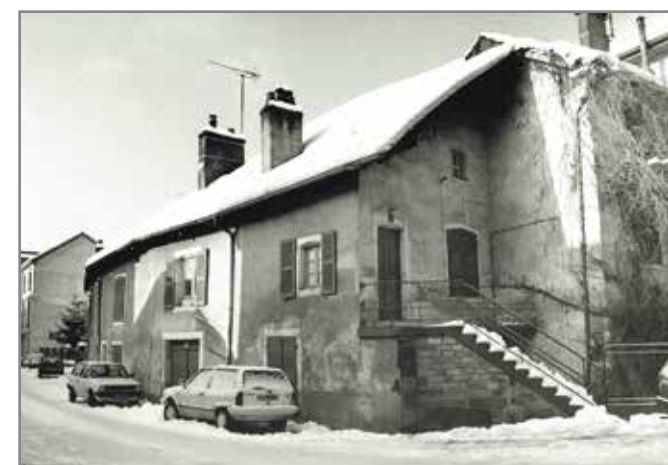
Vue des bâtiments et de la rue des Cannes vers 1990. L'immeuble du XVIII e siècle a subi des transformations au cours des siècles qui suivirent. Image : Philippe Kahn.
