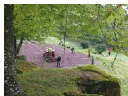
Opération d'épandage des graviers.
