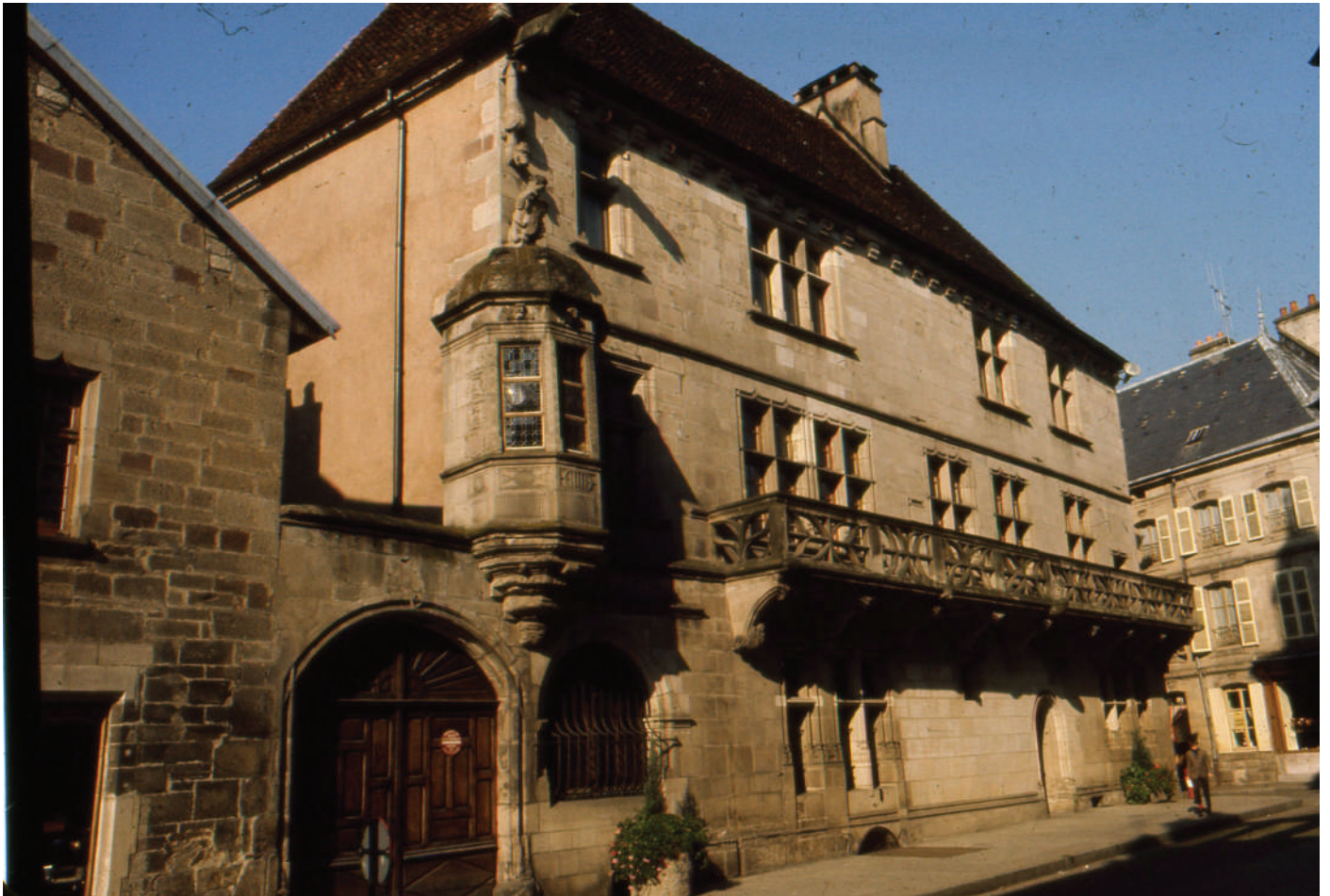
Façade de la Maison Jouffroy, photo P. Kahn
