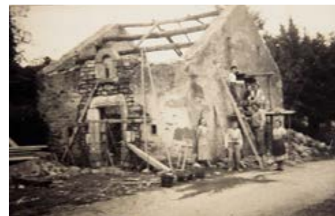
Les murs de la future chapelle ont la hauteur définitive des murs et la fenêtre à meneaux est installée (1958-1962)
