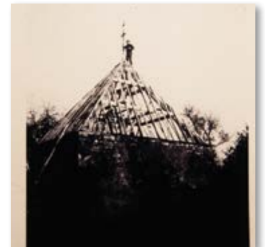
Installation de la charpente, de la croix et du coq (vers 1960)
