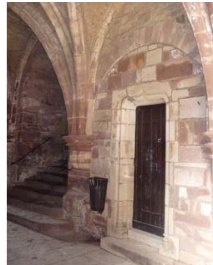
Porte d'accès au rez-de-chaussée de l'appartement du gardien située à gauche de la grande grille du porche (Image 3)
