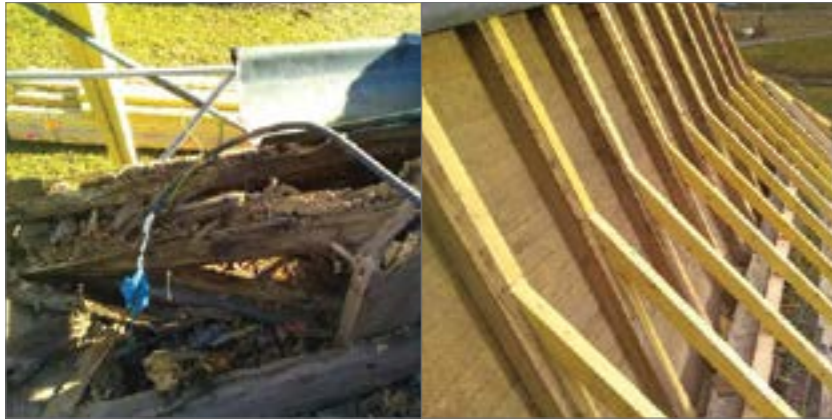
L'état des coyaux après dépose des tuiles (image Joseph Géhant)
