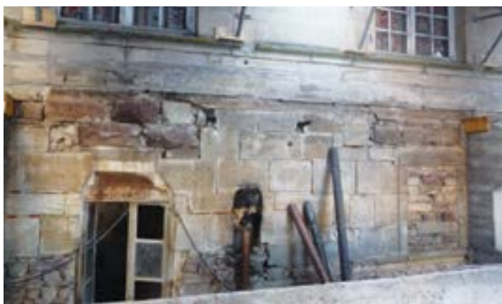
Fenêtre de la chambre du gardien et tuyau du poêle de la cuisine au rez-de-chaussée. À droite de l'image une des fenêtres murées donnant dans la hall des moines (Image 9)
