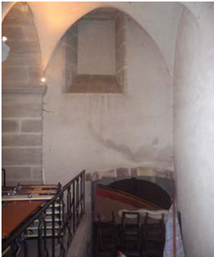
2017, avant la construction des toilettes, accès au cloître depuis le hall des moines. Photo réalisée avant la construction des toilettes au-dessus de l'escalier (Image 5)
