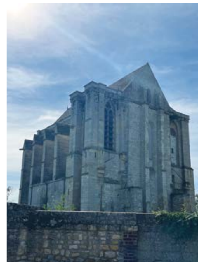
Montiers, église abbatiale Saint-Martin
