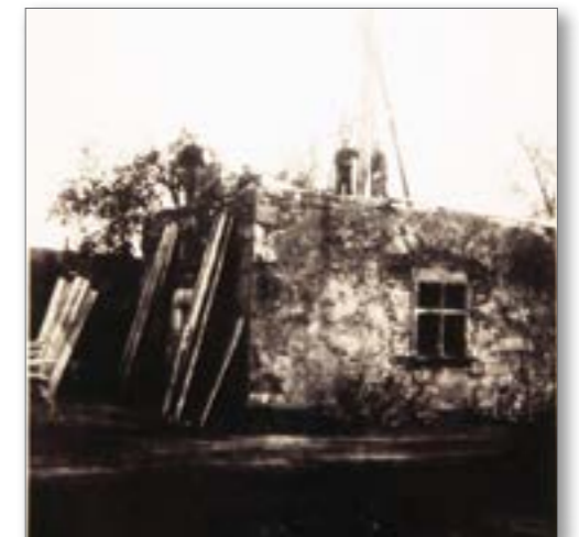
Dépose de la charpente de la grange, installation de l'embrasure de porte de style renaissance (1958-1962)
