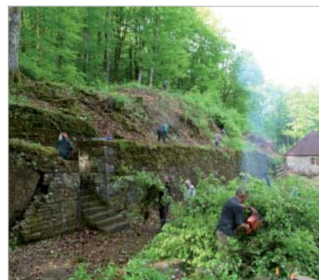
Le talus en cours de nettoyage.
