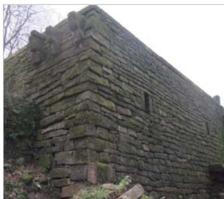
Le mur rénové.
