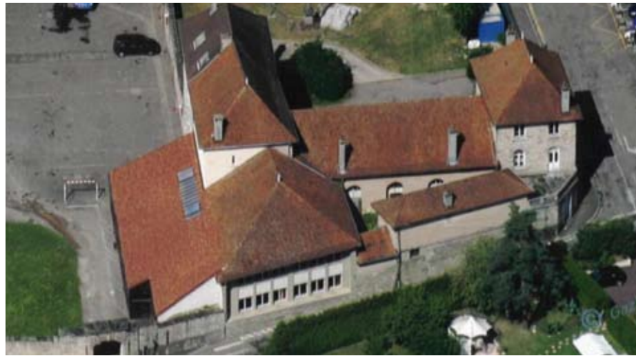
L'ensemble des bâtisses de la Cité, avant réhabilitation.
