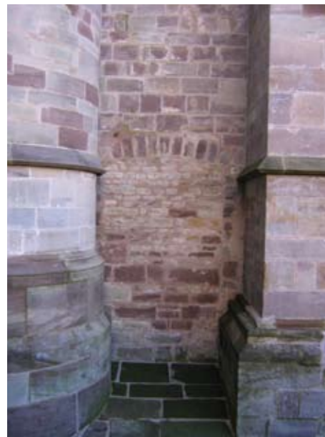
L'accès à l'église Notre-Dame depuis l'église saints Pierre et Paul. Cette porte aujourd'hui murée est situé derrière le groupe de Notre-Dame de Pitié à l'extrémité est du bas côté nord.
