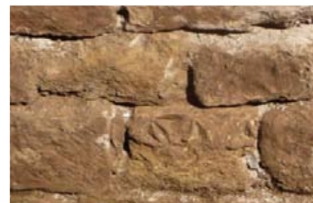
Bloc sculpté de motifs floraux et d'entrelacs en emploi dans le mur. Permet de dater la construction au Moyen âge (sondage 3).
