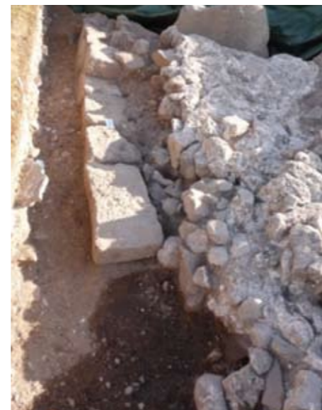
Détail du mur de l'abside nord (sondage 2).
