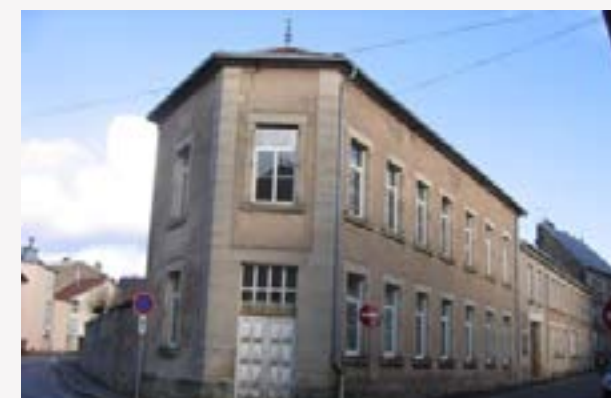
Le bâtiment avec un étage construits dans les années 1930 par le Père Henri Thiébaud, curé de Luxeuil. Image 1925.
