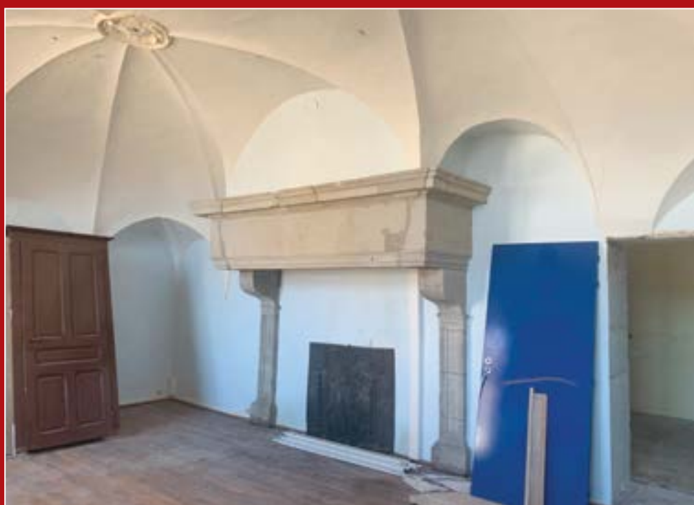
Le chauffoir installé à l'extrémité nord du grand quartier
