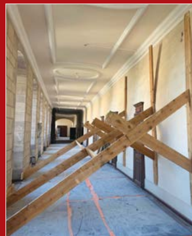
Consolidation des cloisons du 1 er étage avant dépose
