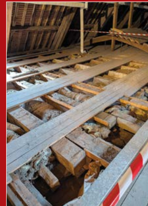
Consolidation des poutres et des solives du plancher au grenier
