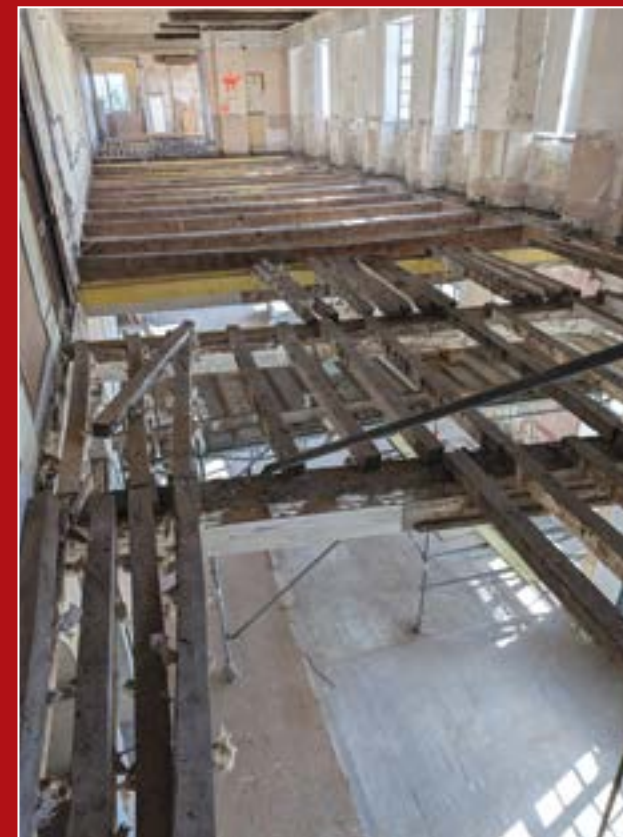
Consolidation des poutres et des solives des planchers du 1 er et 2 ème étages
