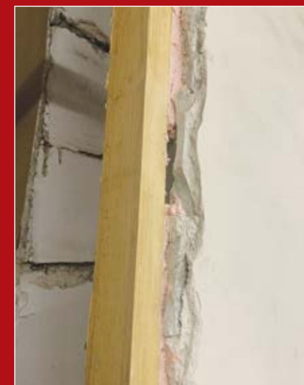
Les cloisons du XVII e siècle avec une pierre en grès maintenue par une armature en bois et en ciment
